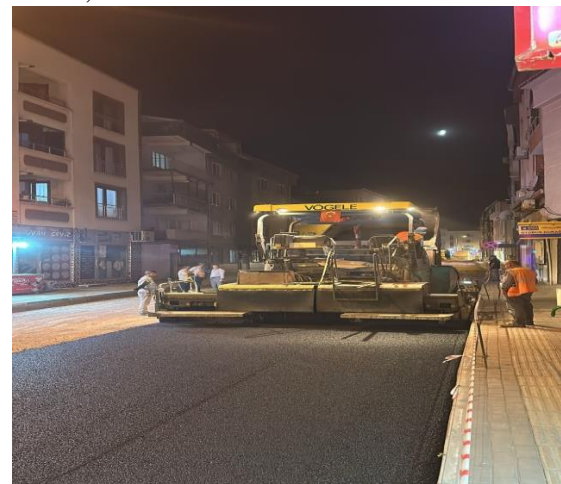
Vani Mehmet Mahallesi Şehit Nizamettin Yavlak Caddesi Asfalt Çalışması
