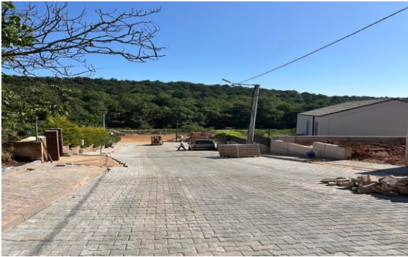
Kazancı Mahallesi Kilitli Parke Taşı Çalışması
