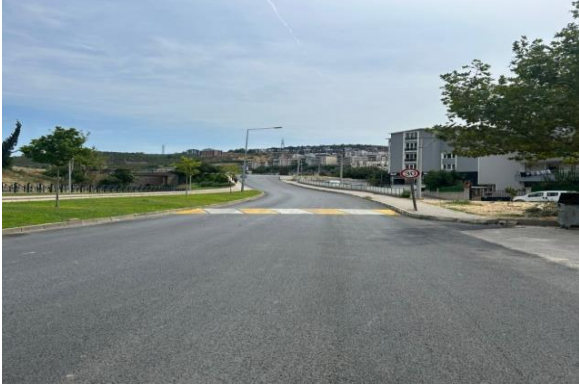
Kale Mahallesi Mandıras Caddesi Asfalt Çalışması
