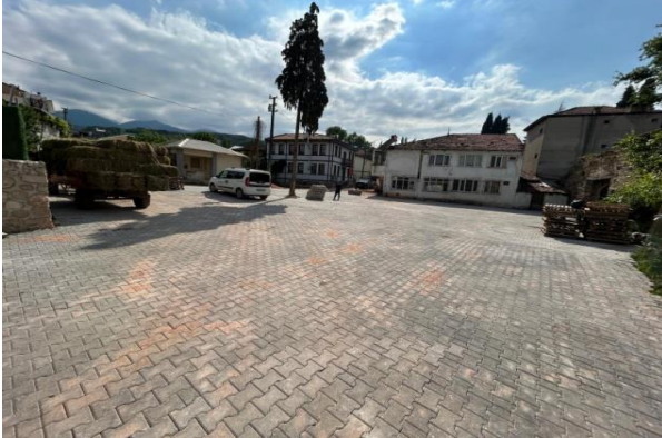
Aksu Mahallesi Parke Taşı Çalışması
